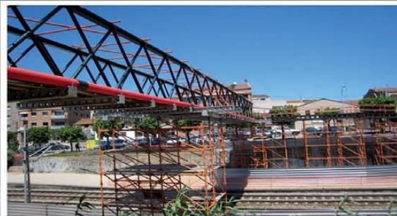
Pasarela Peatonal sobre ferrocarril, Montmeló, Barcelona- FERROVIAL
