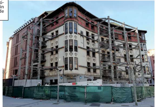
Edificio Cooperativa Bide Onera, Barakaldo- GRUPO EIBAR
