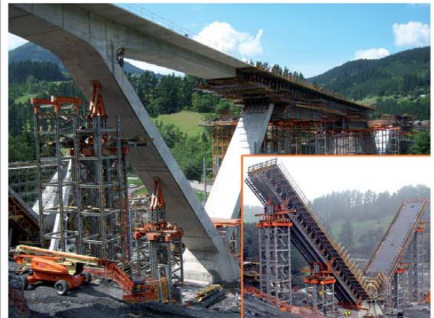
Viaducto Basagoiti, Mondragón- MOYUA, DRAGADOS, OBRAS SUBTERRÁNEAS, GEOTÚNEL
