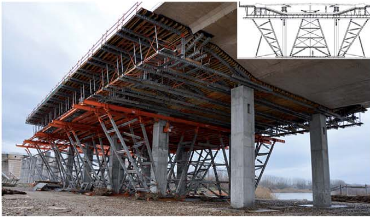
Puente Atirantado Ronda Sur, Talavera- SACYR, AGLOMANCHA, J. BARCENAS
