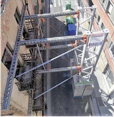
C/ Mayor Antigua 69, Palencia- BERCOPA Los contrapesos separados de la fachada estabilizada permitieron crear un pórtico con SuperSlim y Granshor para dejar un paso para vehículos bajo el propio estabilizador.
