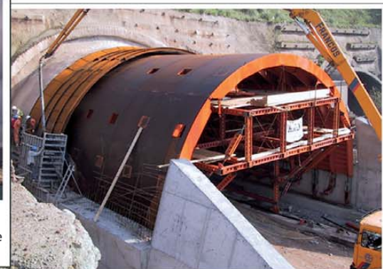
Túnel Sierrapando, Var. Torrelavega- ELSAN, SACYR
