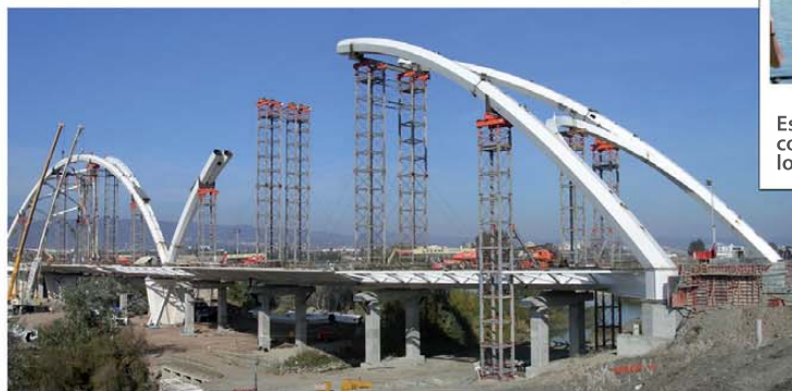
Nuevo Acceso Aeropuerto de Córdoba- TECADE GROUP
