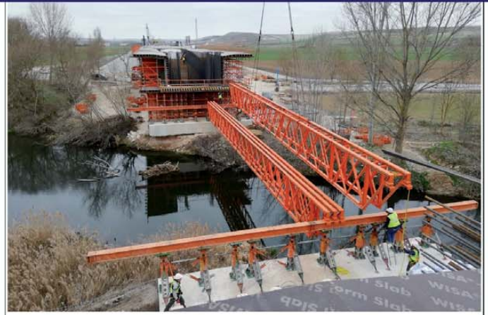
Viaducto s/ Río Arlanzón, Burgos- ADIANTE, TORRESCÁMARA
