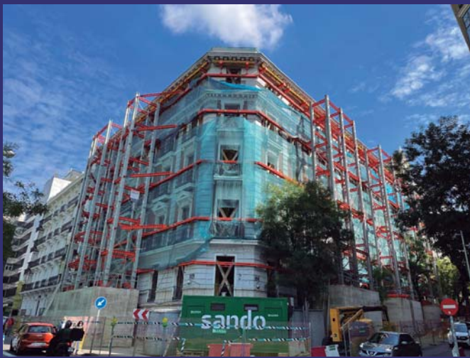
Estabilizadores de fachada
