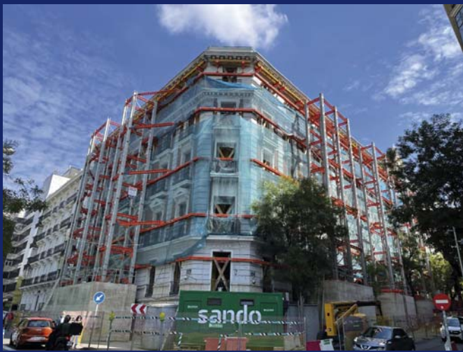
Étançonnement de façade
