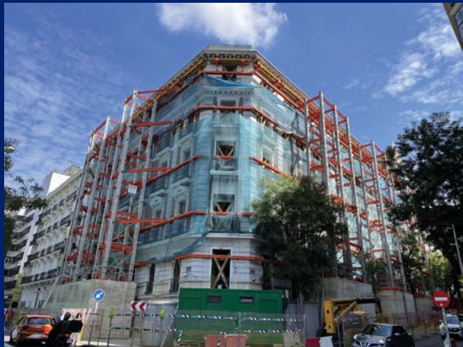
Estabilizadores de fachada
