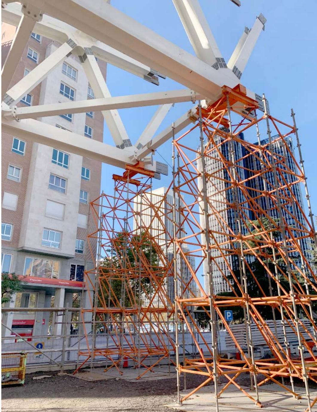
Torres de cimbra **Kwistage** para el **apoyo de las celosías de cubierta** ya que, debido a su gran canto, era preciso disponer de una estructura de soporte durante su premontaje.
