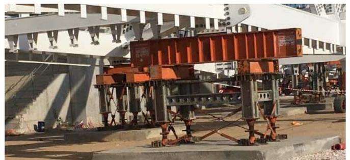
Torres de alta carga **Megaprop** para el apoyo provisional de las distintas porciones de estructura metálica de cubierta y permitir su premontaje.
