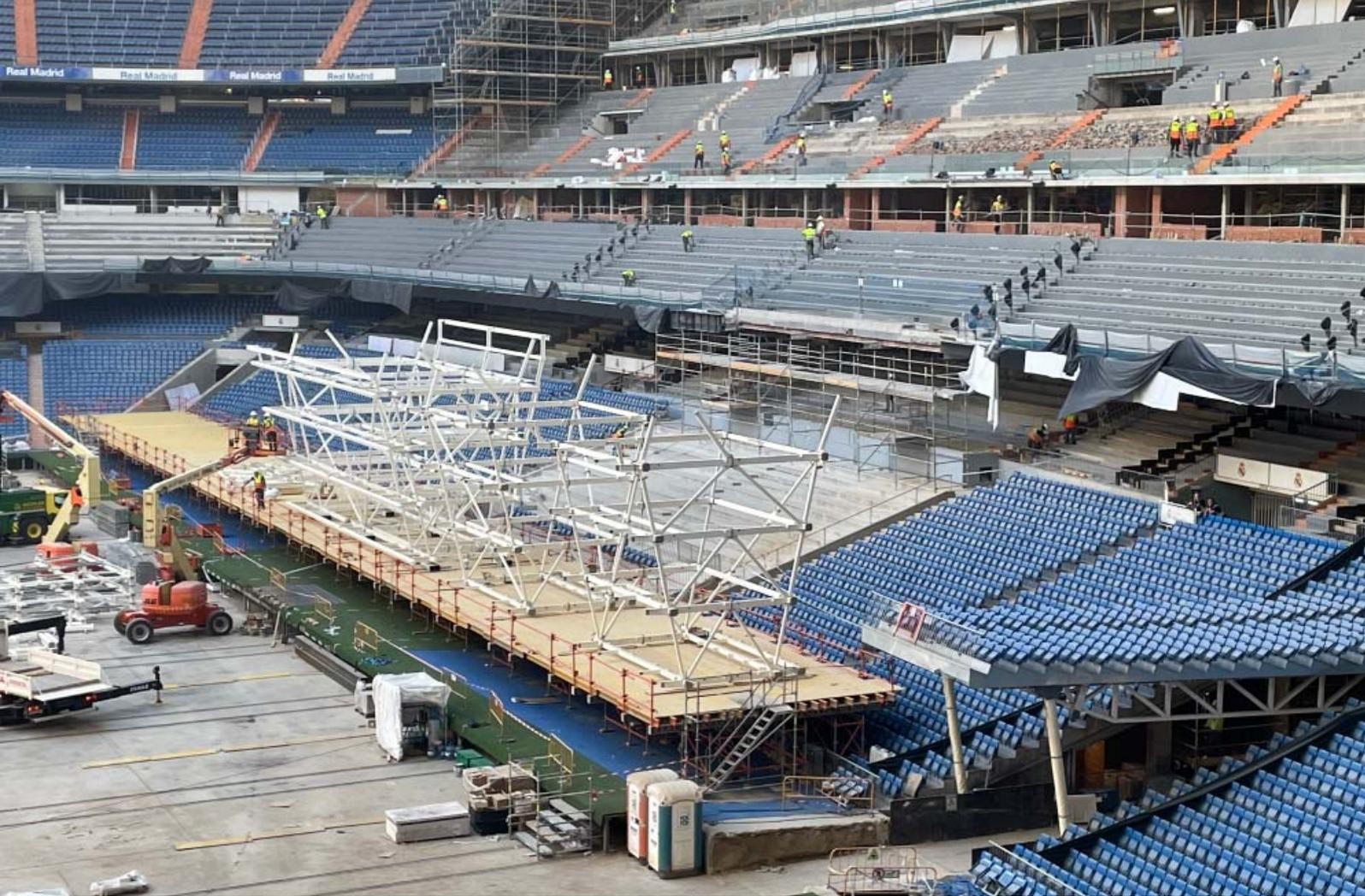
Debido a la necesidad de izar en vertical la **estructura de soporte del videomarcador 360°**, instalamos una plataforma para salvar todos los desniveles de la grada que afectaban al premontaje de la celosía de soporte de los paneles del video.
