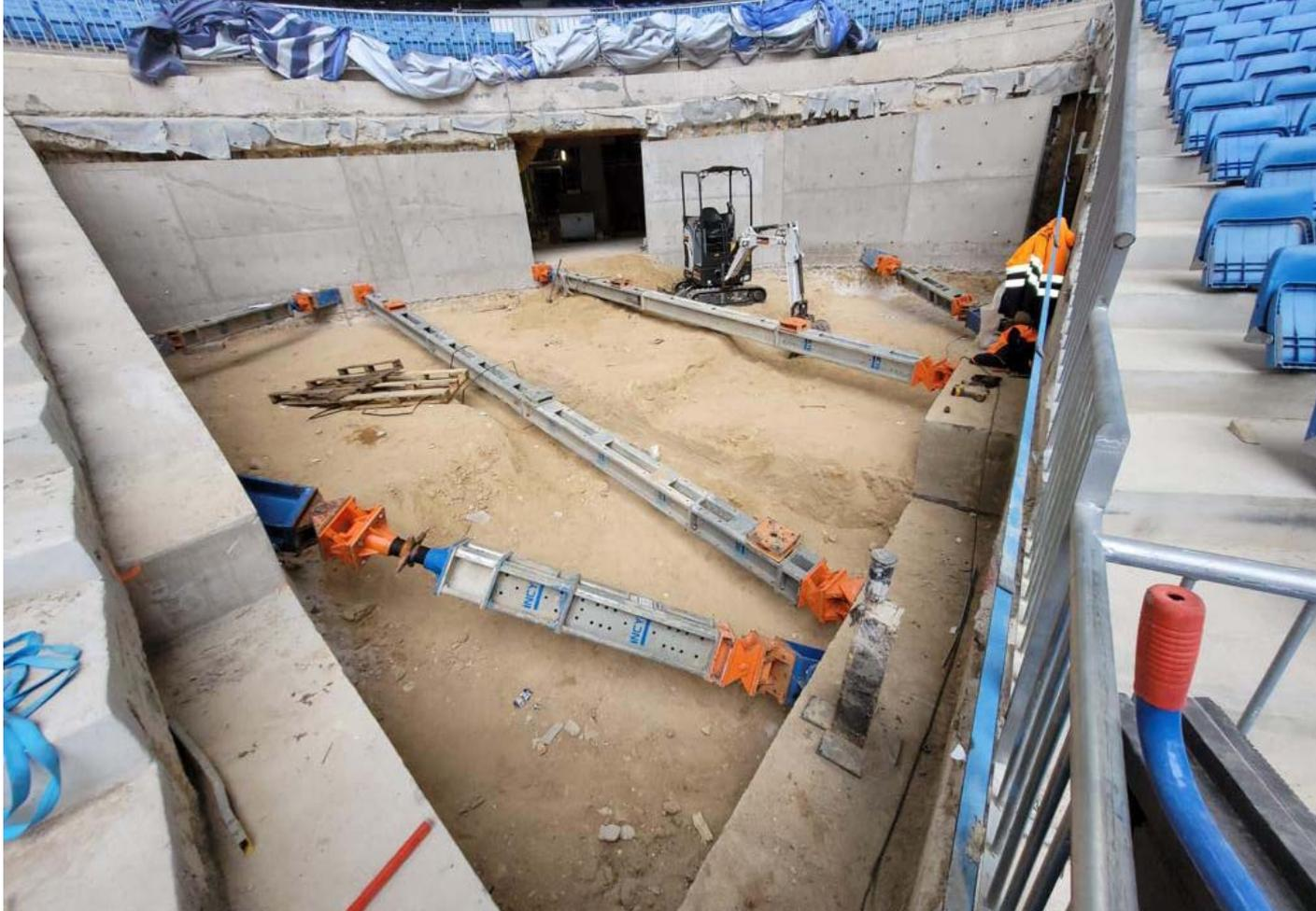
Acodamiento de pantallas para permitir la realización de los pozos de ventilación realizados en los c6rneres del lateral oeste.
