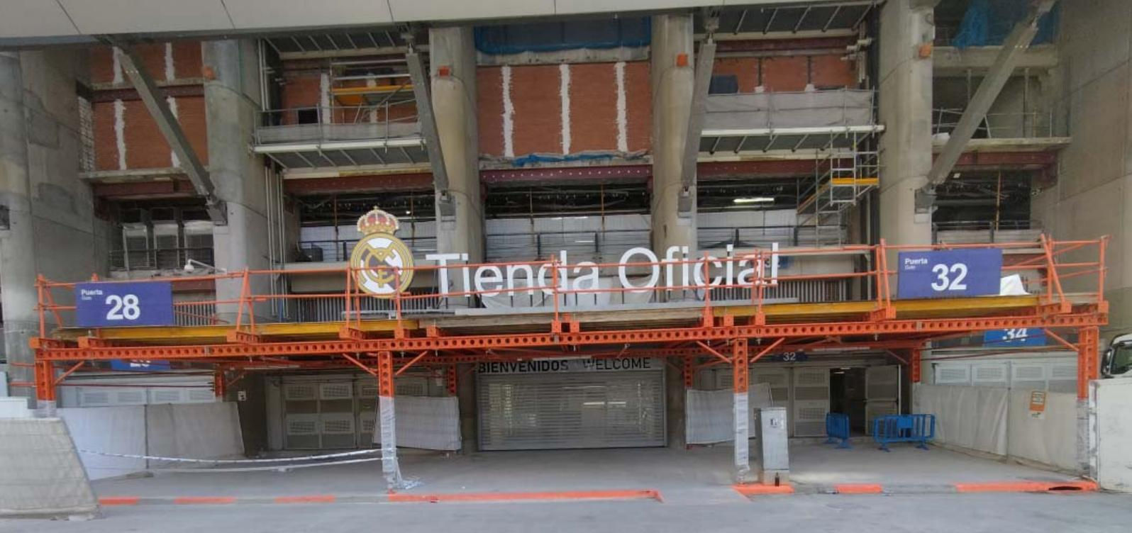
Marquesina de **protección para peatones** formada por vigas metálicas **Superslim**, vigas de madera **T200** y forro fenólico.
