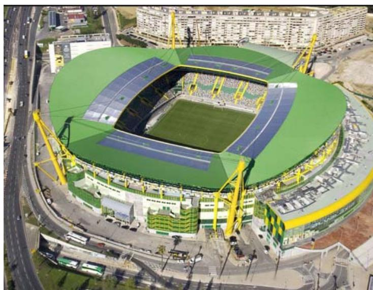
Para el apoyo provisional de la cubierta, diseñamos, suministramos y montamos 24 torres **Megaprop** dobles de **24m** de altura y **3m** de anchura.
