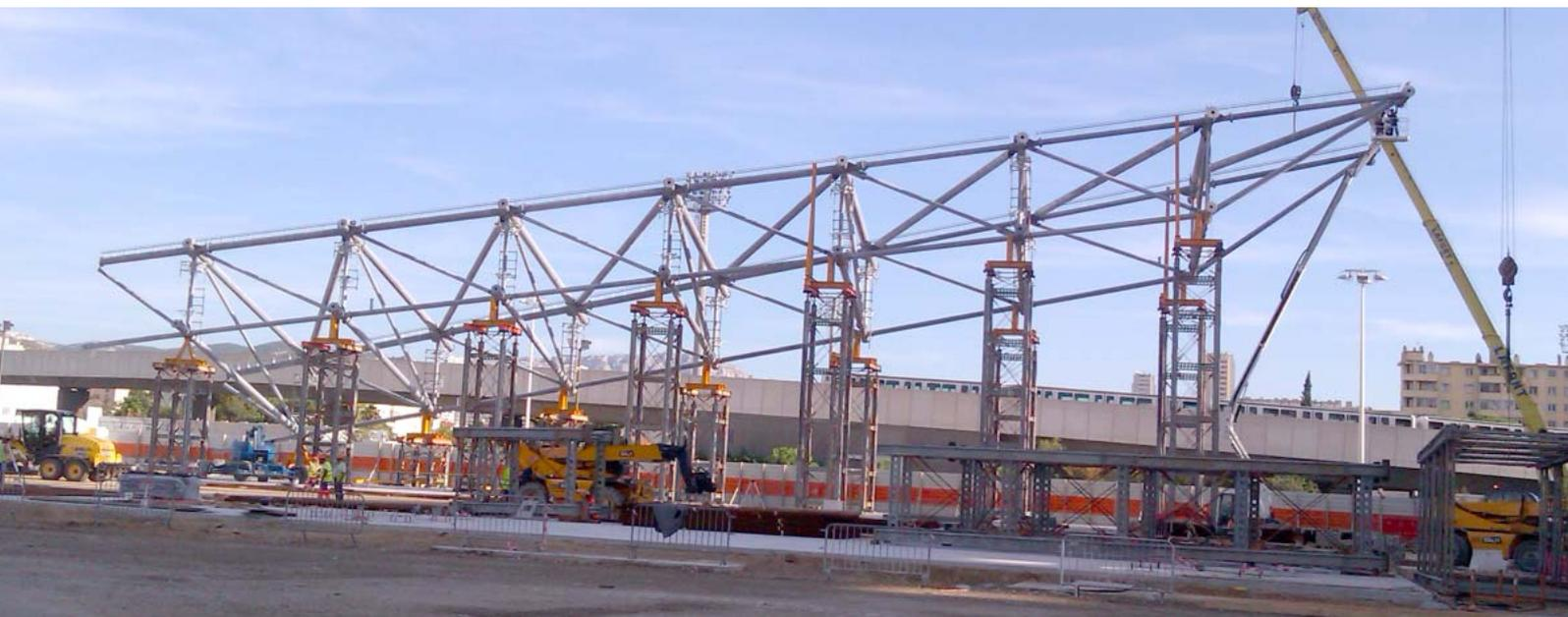
Apeo de cubierta realizado con parejas de torres de alta carga **Megaprop** de hasta 50 m de altura. Las porciones de cubierta tridimensional apoyan sobre estas
