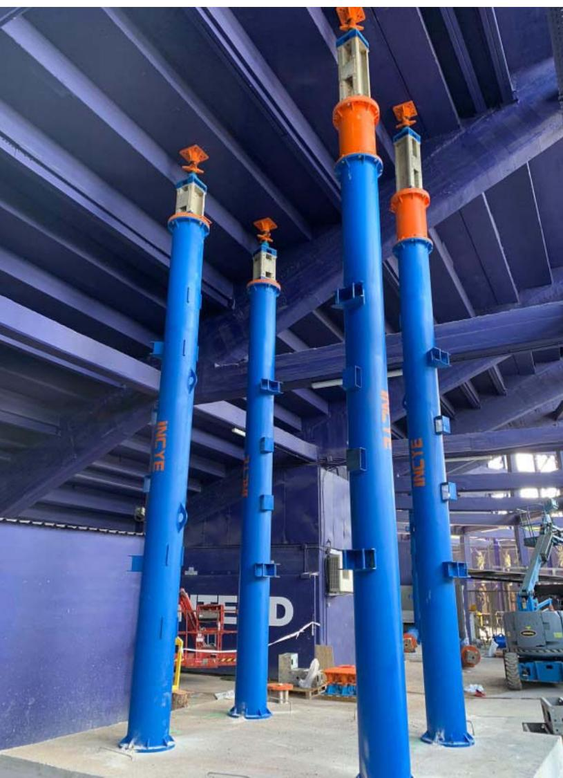
Apeo de cubierta realizado con torres **Megaprop** de hasta 12 m. de altura para la remodelación del estadio del LEVANTE UD.
