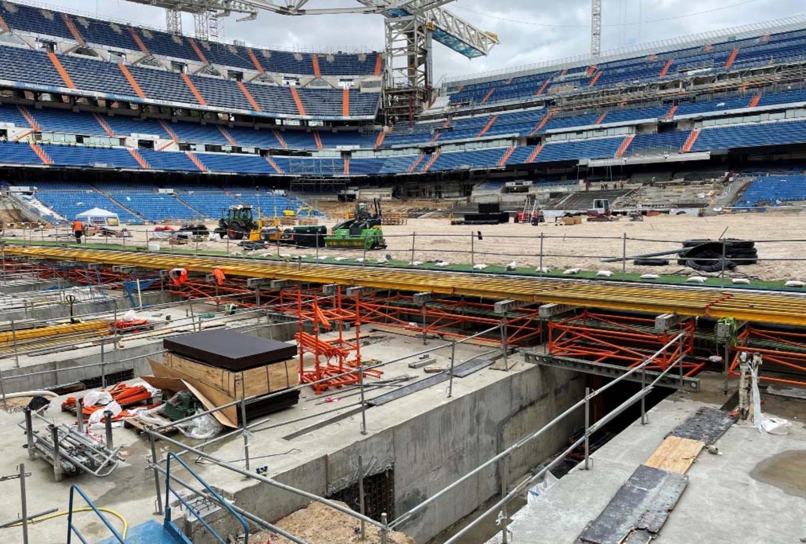
Durante la realización de las obras y hasta la instalación completa del **hipogeo**, instalamos unas **plataformas con césped sintético azul** necesarias para disponer de una zona segura para los recogepelotas, paso para servicio de mantenimiento y zona de estancia de personal de prensa. Realizadas con cimbra **Kwikstage**, vigas **Superslim**, vigas **T200** y forro fenólico antideslizante y nuestra valla de protección **Ultraguard**.
