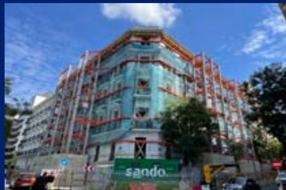
Estabilizadores de fachada 4
